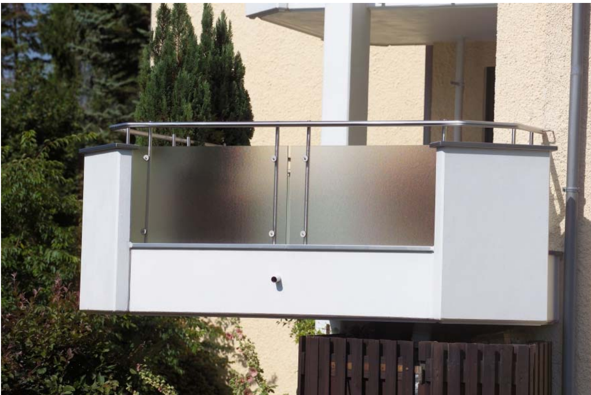
Bild2: Beispiel einer erfolgreichen Balkonsanierung
